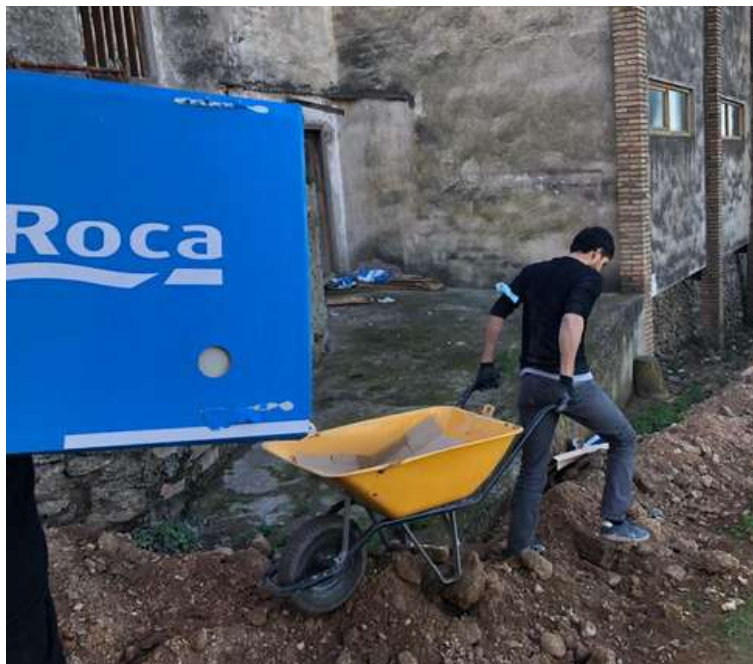
Rehabilitació a Ca'n Illescas, Molins
