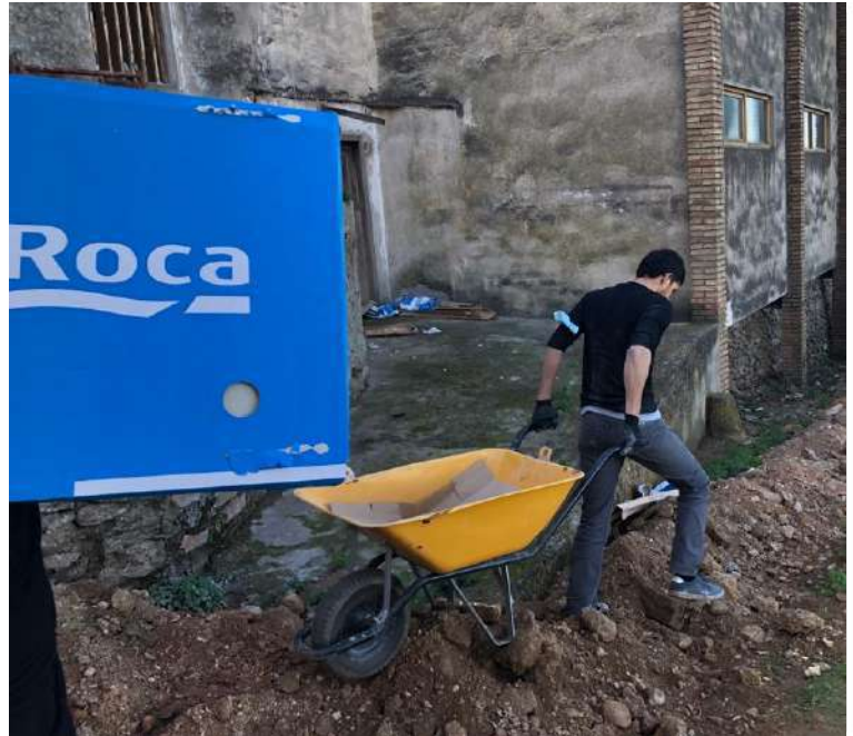
Rehabilitación en Ca'n Illescas, Molins
